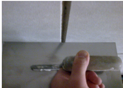
* Detail Kontrolle Plattenkante / Stoßfuge auf Sichtseite
