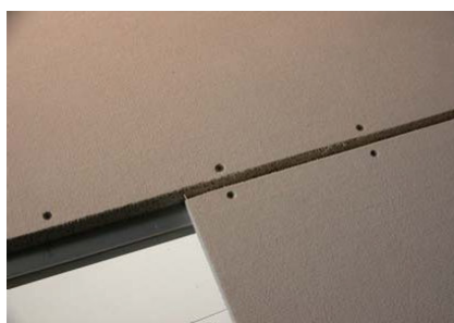
Detail Plattenstoß mit Verschraubung (Sichtseite)
